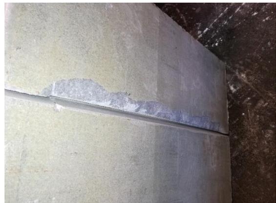
Figura 20. Modo de rotura bajo carga gravitatoria y succión de viento. Sección 1-1' [6]
