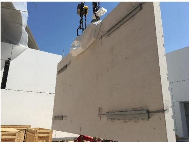
**Figura 21. Pletinas fijadas al panel mediante adhesivo epoxi**
