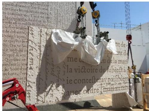
**Figura 23. Izado de un panel**
