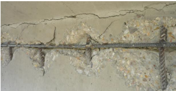
Figura 15. Detalle de deformación de los cercos.
