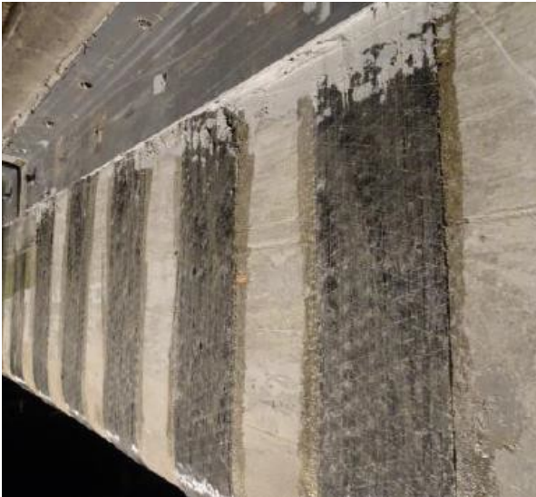
Figura 16. Sistema de anclaje del refuerzo a cortante.
