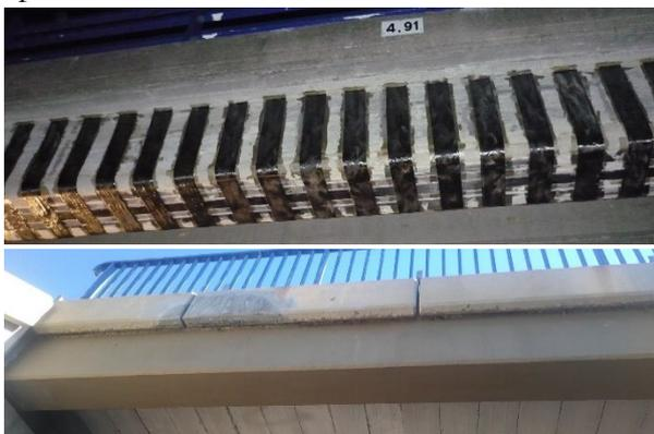
Figura 17. Mortero impermeabilizante aplicado en vigas. (Asistencia técnica de las obras de reparación y refuerzo de las vigas impactadas en la estructura de la N-120 en el P.K. 311+200 (León); julio de 2019)
