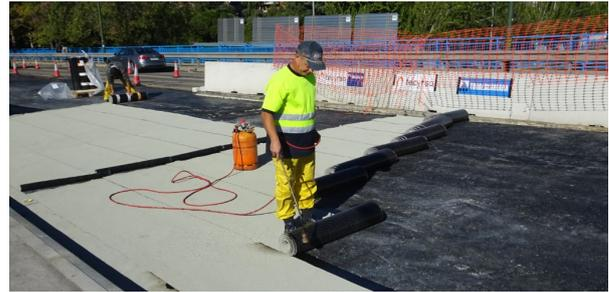
**Figura 9. Impermeabilización mediante lámina asfáltica (Asistencia técnica de las obras de rehabilitación del puente de la Paz (Madrid); noviembre de 2017)**
