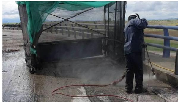
Figura 2. Trabajos de hidrosabado en la losa (Asistencia técnica de las obras de rehabilitación del paso superior situado en el P.K. 45+300 de la A-5 (Madrid); mayo de 2019)
