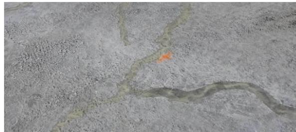
**Figura 5. Sellado de fisuras en el recrecido de hormigón UHPCFR (Asistencia técnica de las obras de rehabilitación del paso superior situado en el P.K. 45+300 de la A-5 (Madrid), mayo de 2019)**
