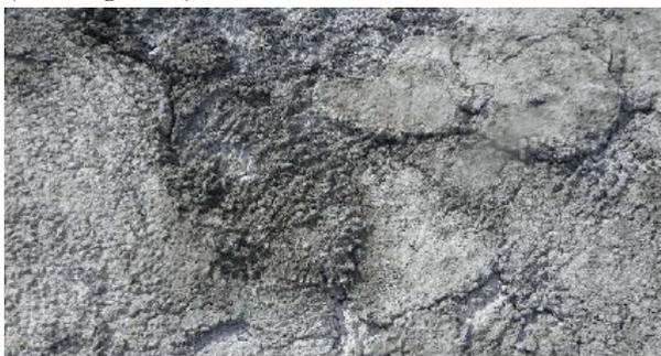
**Figura 4. Acabado superficial del recrecido de hormigón UHPCFR (Asistencia técnica de las obras de rehabilitación del paso superior situado en el P.K. 45+300 de la A-5 (Madrid), mayo de 2019)**
