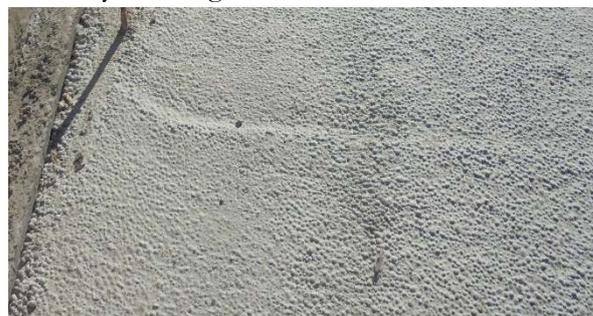
**Figura 6. Acabado superficial del hormigón ligero. (Asistencia técnica de las obras de rehabilitación del puente de Los Franceses (Madrid); septiembre de 2017)**
