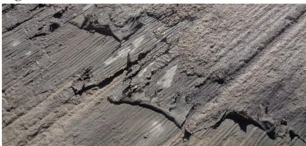
Figura 1. Lámina de impermeabilización al descubierto tras el fresado del pavimento (Asistencia técnica de las obras de rehabilitación del puente de la Paz (Madrid); noviembre de 2017)
