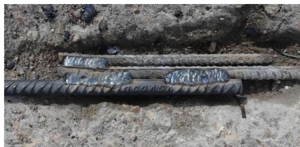
Figura 3. Soldado de las barras de la losa (Asistencia técnica de las obras de rehabilitación del paso superior situado en el P.K. 45+300 de la A-5 (Madrid); mayo de 2019)
