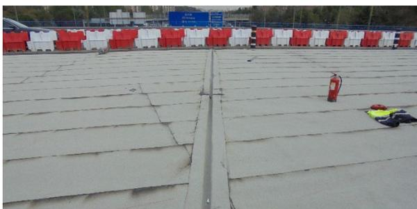
**Figura 11. Encuentro de la impermeabilización del con la junta de dilatación (Asistencia técnica de las obras de rehabilitación del puente de la Avenida del Mediterráneo (Madrid); noviembre 2017)**
