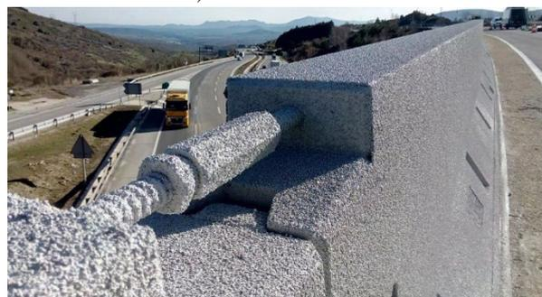
**Figura 16.** Aplicación de corcho proyectado en sistema de contención. (Asistencia técnica de las obras de rehabilitación del puente en el P.K. 90+720 de la autovía A-1 en Madrid; marzo de 2017)
