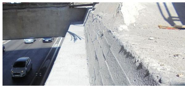
**Figura 15.** Corcho proyectado en ménsulas de juntas a media madera. (Asistencia técnica de las obras de rehabilitación de los apoyos a media madera del puente de la Avenida del Mediterráneo (Madrid); septiembre de 2017)
