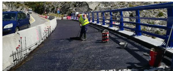
Figura 13. Impermeabilización del tablero mediante mortero bituminoso. (Asistencia técnica de las obras de rehabilitación de la estructura sobre el arroyo del Puerto del Pico (Ávila); octubre de 2019)
