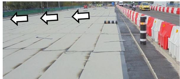
**Figura 10. Impermeabilización del tablero mediante lámina asfáltica (Asistencia técnica de las obras de rehabilitación del puente de la Avenida del Mediterráneo (Madrid); noviembre 2017)**
