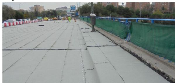
**Figura 12. Impermeabilización de la acera mediante lámina asfáltica (Asistencia técnica de las obras de rehabilitación del puente de la Avenida del Mediterráneo (Madrid); noviembre 2017)**
