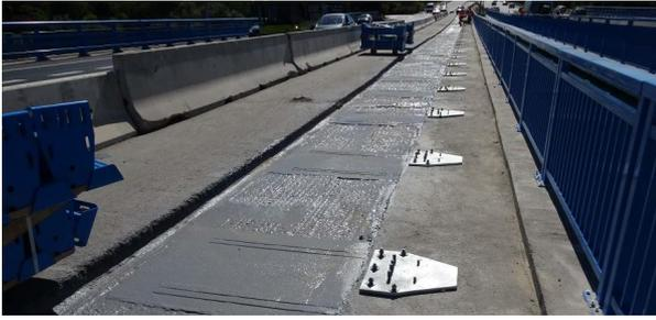
**Figura 8. Impermeabilización de refuerzos de fibra de carbono (Asistencia técnica de las obras de rehabilitación de los puentes de O'Donnell (Madrid); agosto 2018)**
