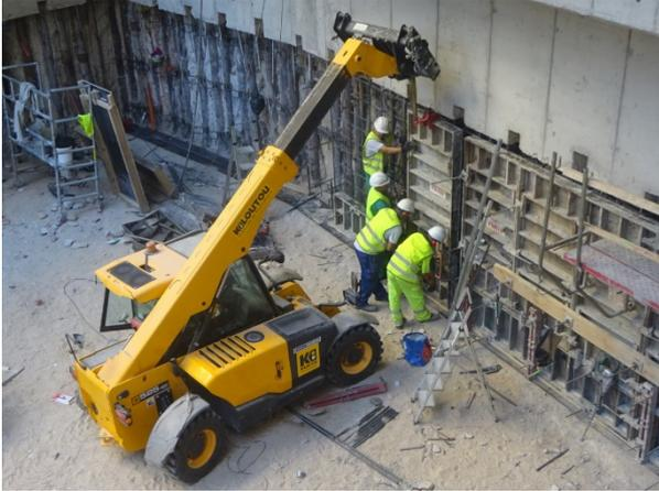
Figura 10. Ejecución tramos de muro forro
