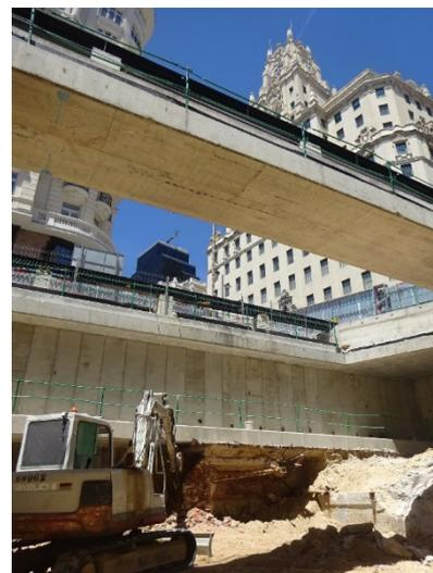
Figura 9. Viga cargadero de cubierta
