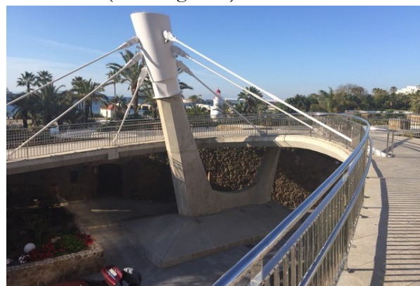
Figura 7. Detalle de barandilla de acero inoxidable en entrada desde el Paseo Marítimo.
