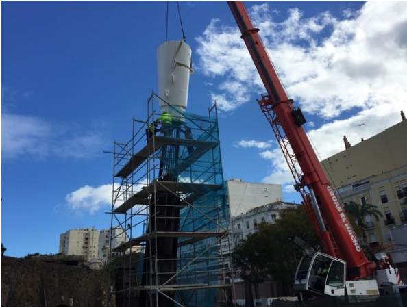
Figura 15. Fotografía correspondiente a la colocación del caperuzón metálico superior.
