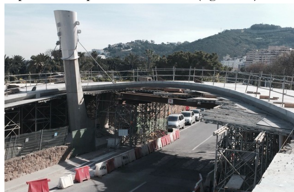
Figura 12. Fotografía de la pasarela sobre cimbra cuajada y porticada durante su construcción.
