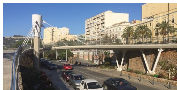
Figura 6. Vista lateral desde el lado del Parque Marítimo, desde el que se observan las pilas en V.
