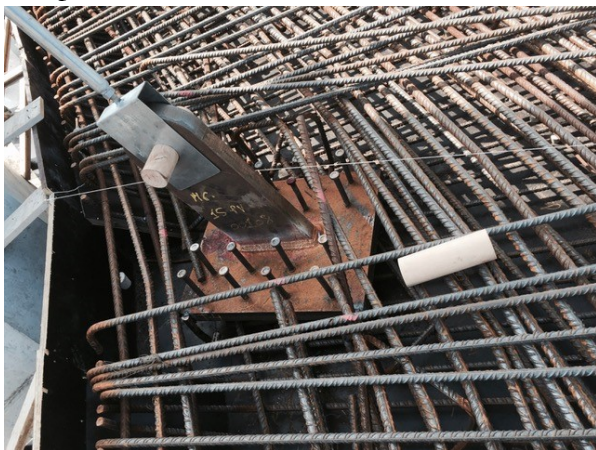
Figura 14. Orejeta y chapa de reparto embebida en tablero, durante proceso de ferrallado.
