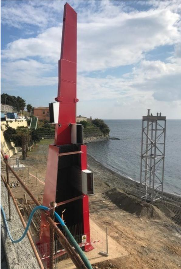
Figura 12. Fotografía del pilono colocado antes del ferrallado y hormigonado del interior.
