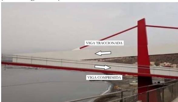
**Figura 10. Esquema de comportamiento estructural de vigas en los tramos volados.**
