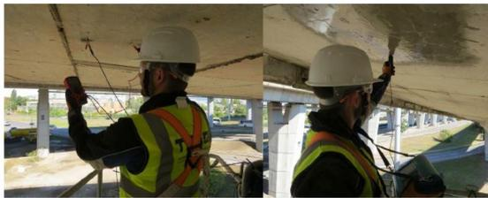
Se ha comprobado el estado de los tendones y la inyección de protección dentro de las vainas mediante cámara endoscópica.
