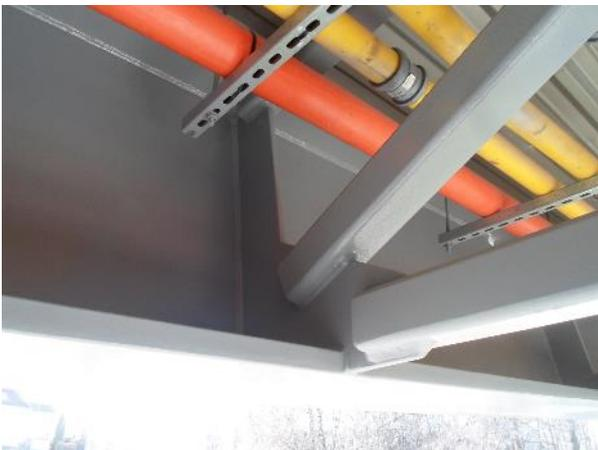
**Figura 5. Conexión de los rigidizadores intermedios.**
