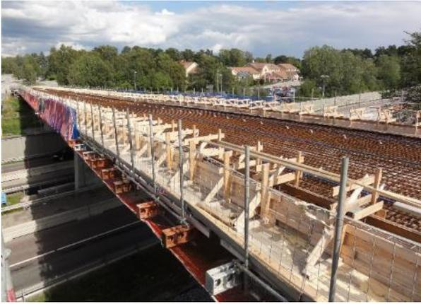
Figura 12. Encofrado no apeado de la losa del tablero.
