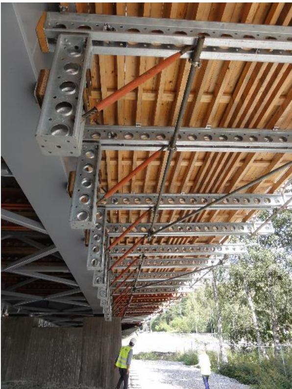
Figura 14. Encofrado no apeado de la losa del tablero.
