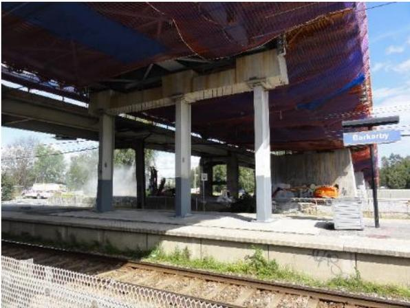
Figura 7. Primera fase del soporte 4 y montaje no apeado del tablero.
