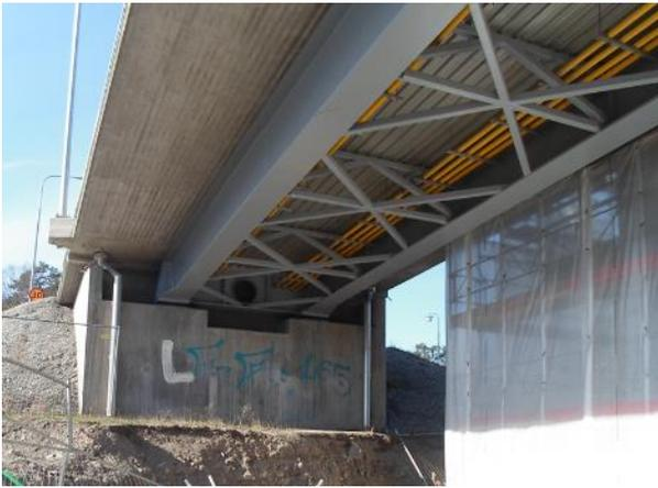
**Figura 4. Diafragma con boca de hombre, rigidizadores intermedios y arriostramiento en diamante.**
