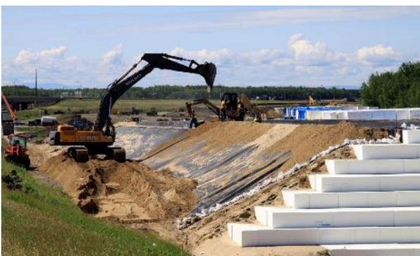
Figura 9. Terraplén con núcleo de cellplast.
