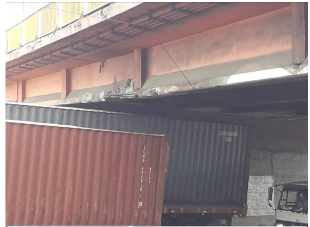
Figura 3. Viga lateral de puente vehicular Santa Rosa sobre la Vía Evitamiento.
