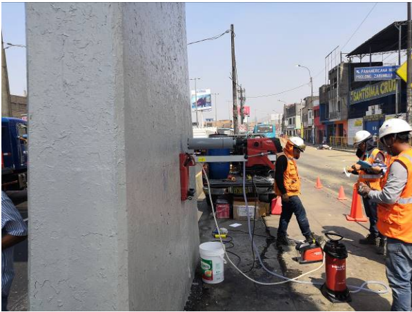
Figura 11. Extracción de testigos en el puente peatonal Porvenir.
