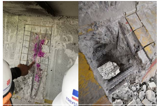
Figura 13. Roza en el centro de vano de la viga acopiada.
