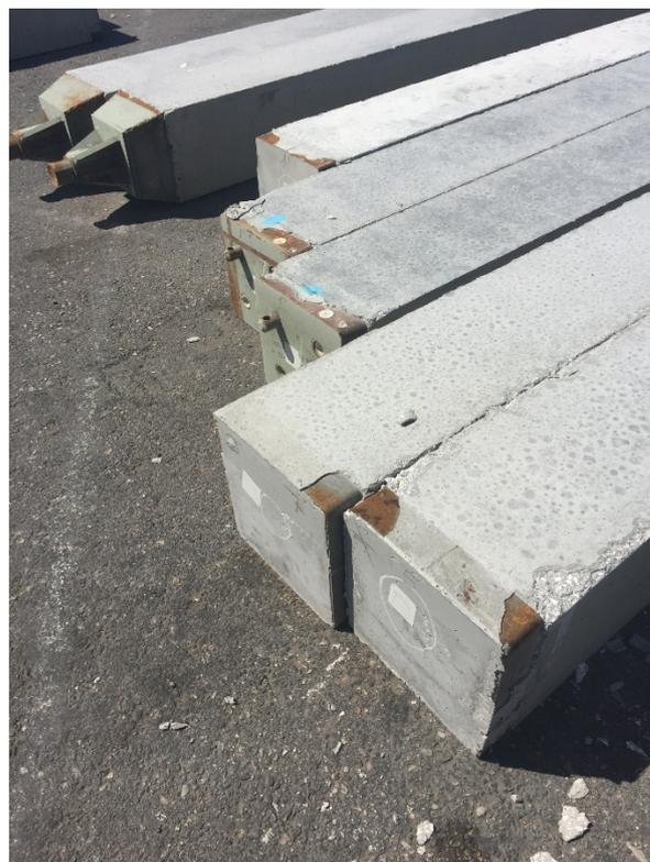
**Figura 10. Cabeza de hincia, junta entre tramos y azuches en pilotes prefabricados.**
