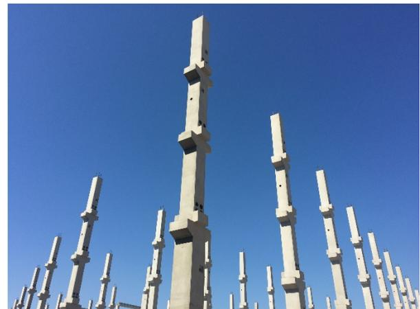
En la planta superior el apoyo de las vigas ya se pudo resolver directamente contra la coronación de los pilares, sin ménsulas cortas, pues el pilar termina ahí.
