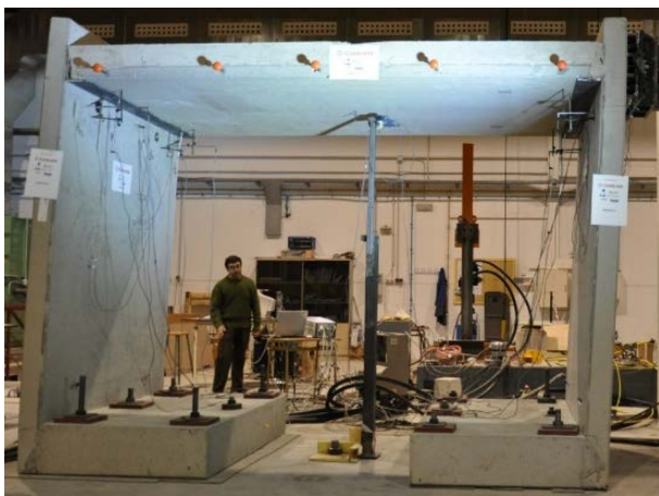
Figura 10. Vista lateral del pórtico durante la fase de tiro.
