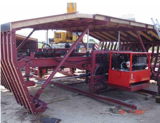
Figura 12. Carro de movimiento de encofrado en posición de prueba
