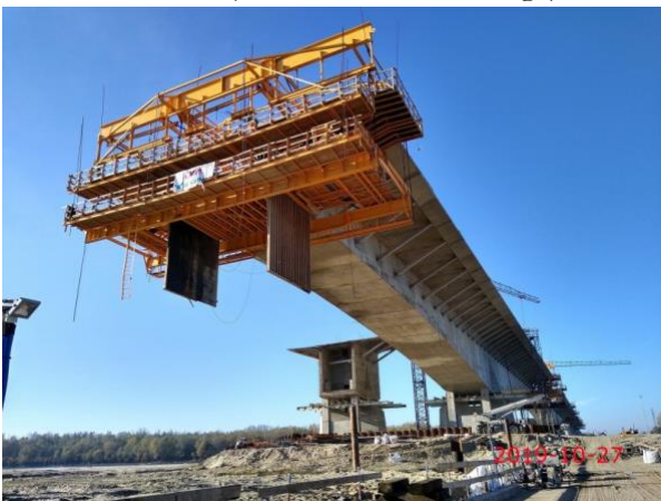
Figura 9. Carro de hormigonado de dovelas en voladizo (Form Traveler)
