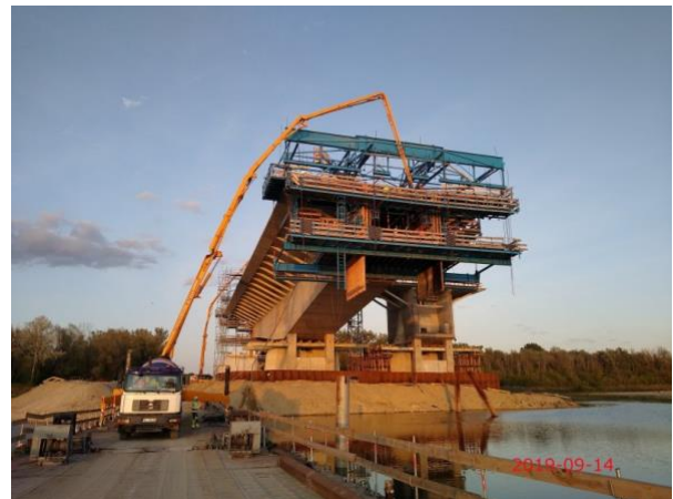
Figura 4. Hormigonado de dovela en voladizo
