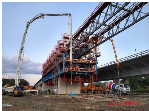
Figura 5. Hormigonado de vano con autocimbra
