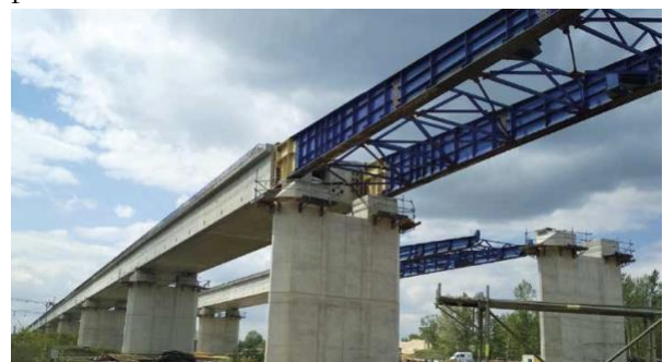
Figura 2. Viga-cajón en fase de empuje
