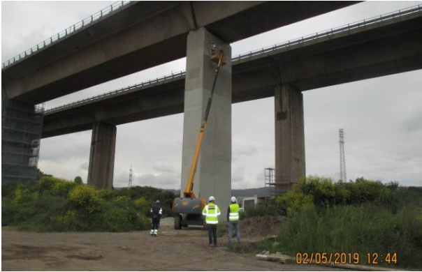
Figura 11. Aplicación de sellante y pintura
