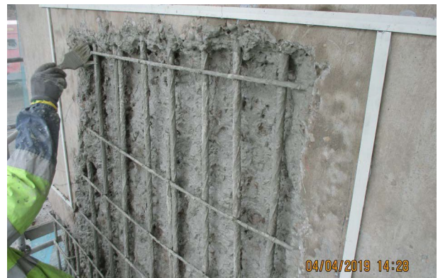
Figura 9. Pasivación de armaduras
