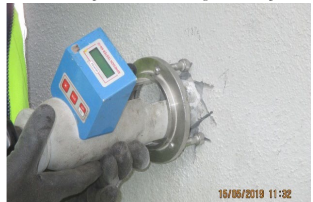
Figura 14. Ensayo de adherencia
