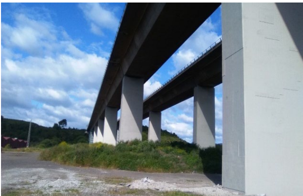
Figura 12. Vista general de las pilas reparadas
