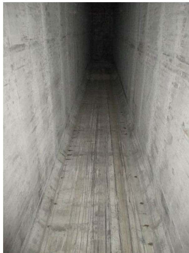
Figura 4. Vista interior de una de las pilas
