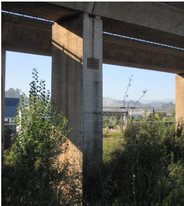
Figura 2. Vista pila rodeada de vegetación
