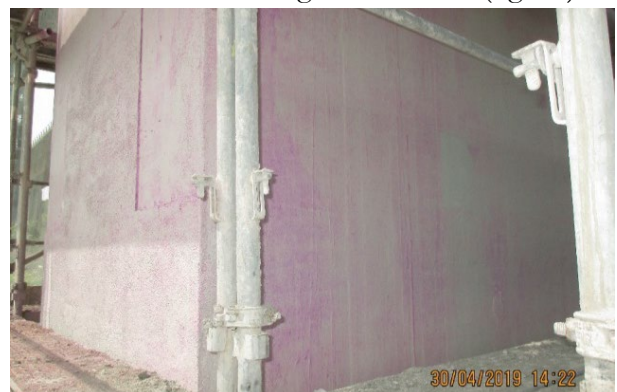
Figura 10. Aplicación del inhibidor
