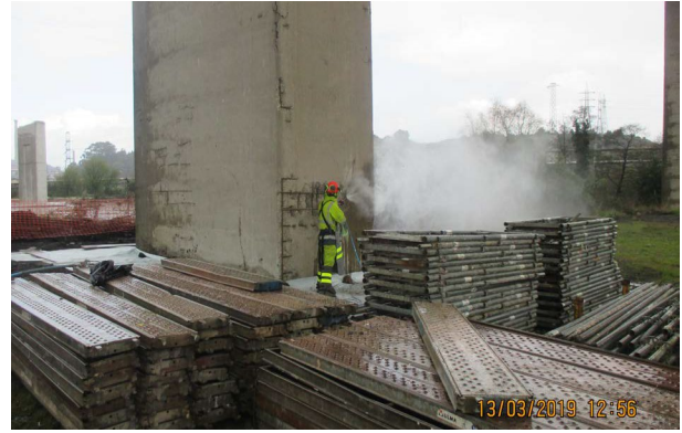
Figura 8. Trabajos de hidrosaneo
