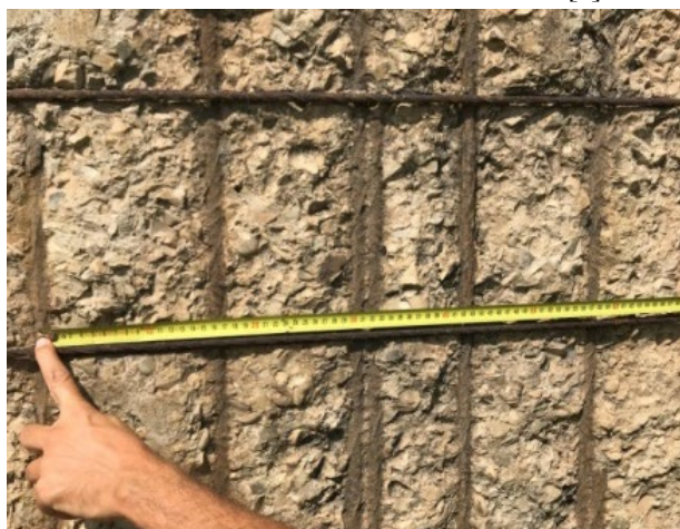
Figura 7. Medición separación barras
