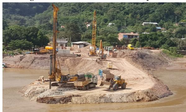
Figura 11. Excavación de pilotes desde la mota.
