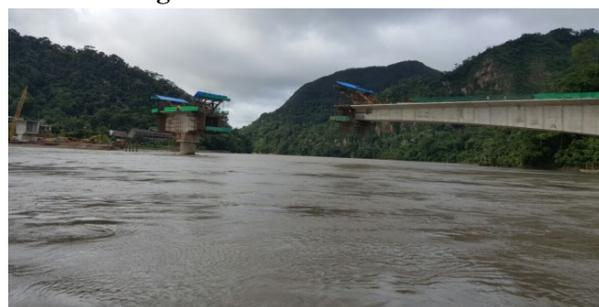
Figura 21. Construcción dovela extrema tablero desde P4 hacia P3.
