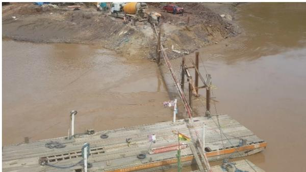
**Figura 22. Bombeo de hormigón hacia P3.**
