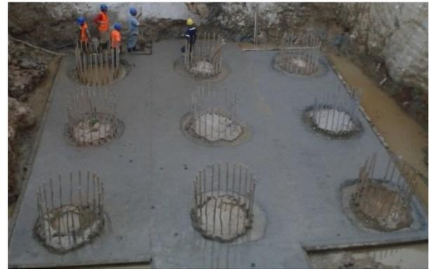
**Figura 14. Hormigón limpieza encepado pilas.**
