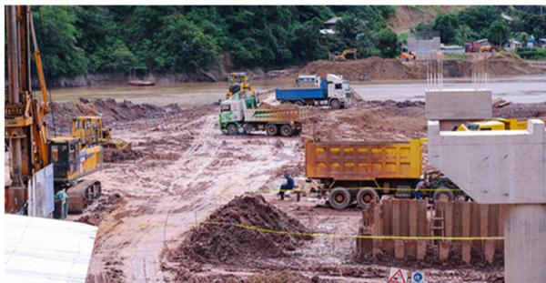
Figura 16. Construcción pilas Viaducto de acceso.
