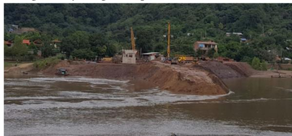
Figura 9. Construcción de la mota.
