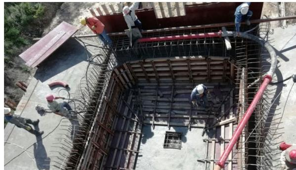
Figura 19. Encofrado dovela “0”.
