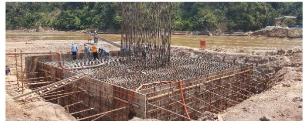
**Figura 15. Ferrallado encepado pilas**
