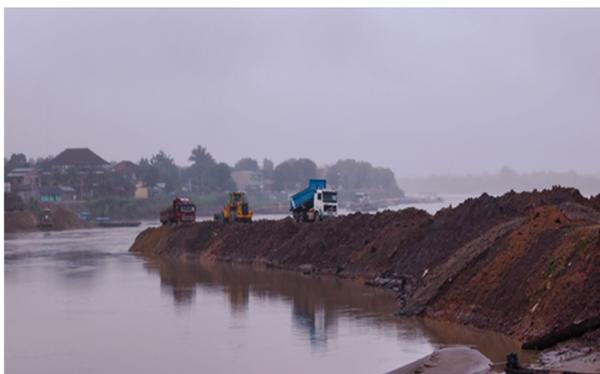
Figura 8. Construcción de la mota.
