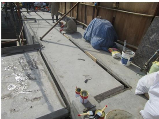
**Figura 13. Reparación de bordes de las juntas**
