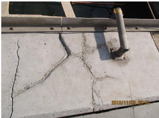
**Figura 17. Preparación y limpieza de fisuras y grietas**
