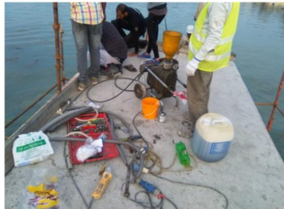
**Figura 19. Inyección de morteros epoxi**
