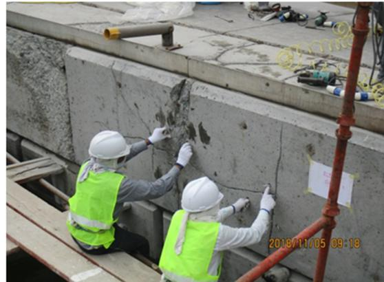
**Figura 18. Instalación boquillas inyección**
