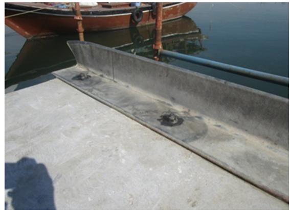
Figura 22. Protección con grasa elementos metálicos
