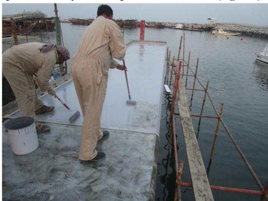
Figura 21. Pintura e la superficie superior del cantil
