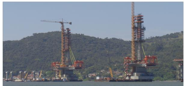
Figura 6. Construcción de atirantado con izadores de dovelas
