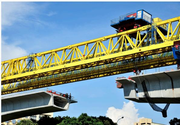
Figura 14. Fase 2 de montaje. Centro de vano
