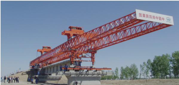
Figura 2. Lanzavigas en fase de colocación de viga
