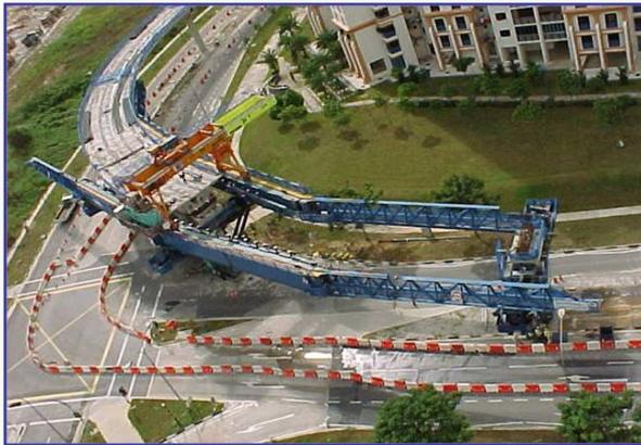
**Figura 10. Montaje de un vano de radio reducido**
