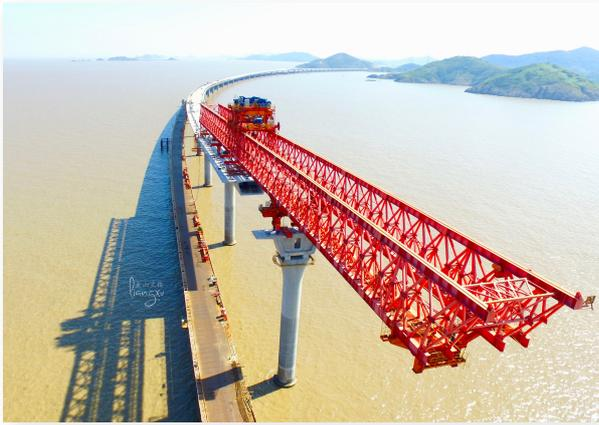
**Figura 9. Ejecución de viaducto con Launching Gantry**
