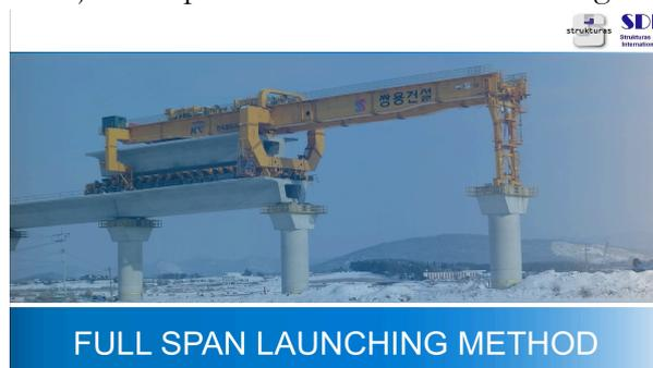
Figura 16. Transporte y montaje de vano completo a temperaturas bajo cero
