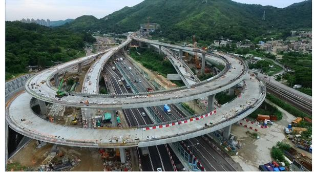
**Figura 12. Viaducto con radio 80m ejecutado con este sistema**
