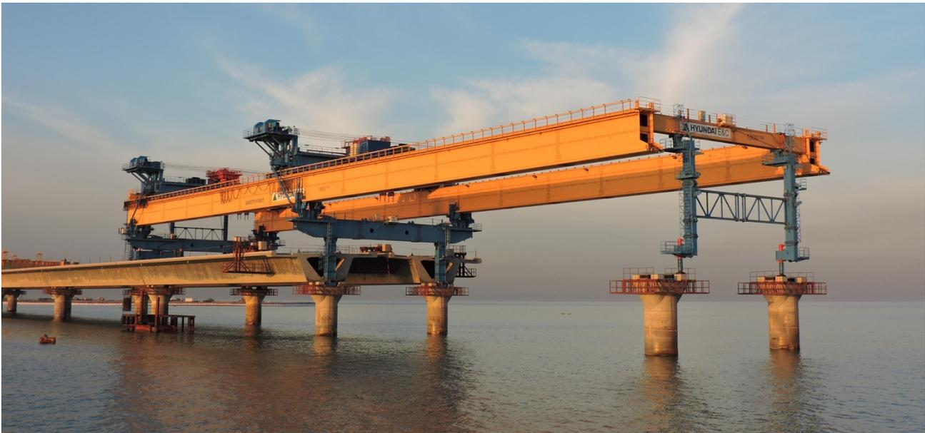
Figura 1. Lanzadera de tableros completos, o lanzaderas Full Span
