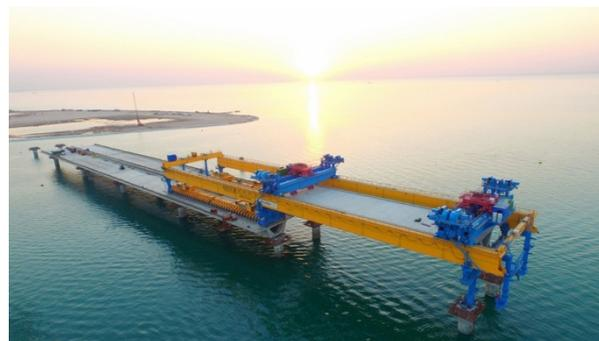
Figura 18. Lanzadera colocando uno de los vanos
