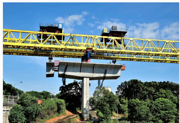
**Figura 13. Montaje de dovelas sobre pila**
