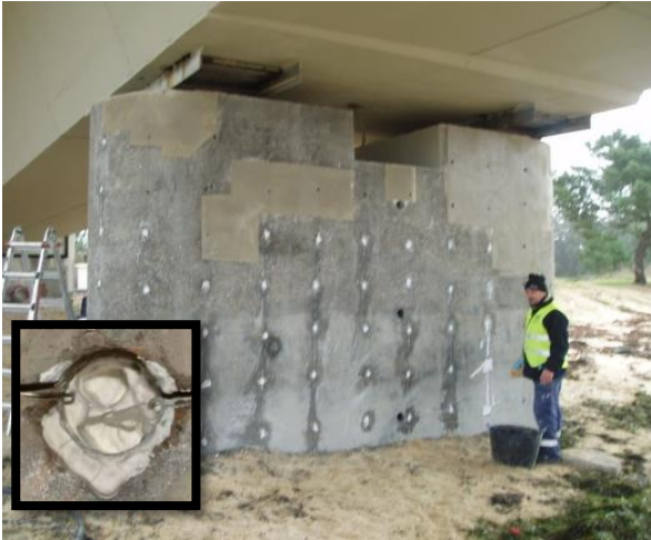
Figura 5. Reparación de las pilas con técnica CPT. Incluye detalle del ánodo de sacrificio colocado.
