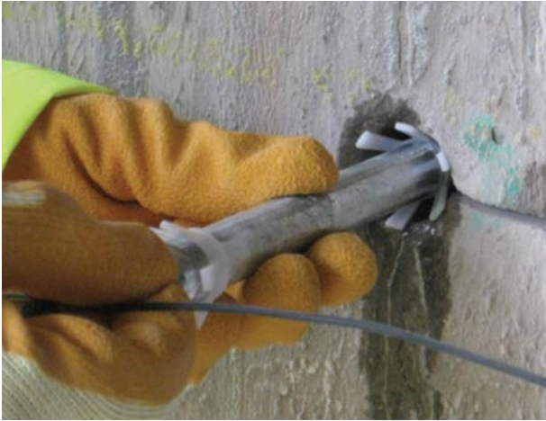
Figura 1. Ejemplo de ánodo de sacrificio
