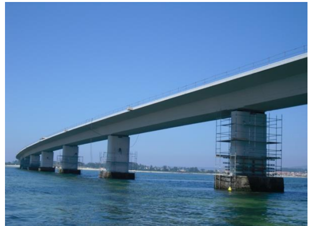
Figura 4. Reparación mediante tecnología Fosroc.
