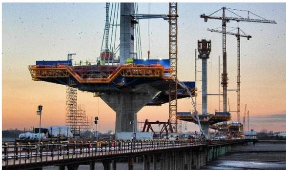
**Figura 9. Carros de avance durante la construcción del tablero [11]**
