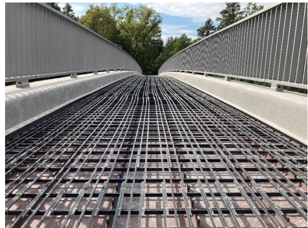
Figura 12. Vista del paso superior A400
