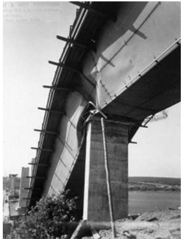
Figura 1. Puente de Milford-Haven después del colapso. 2 de Junio de 1970, [4]
