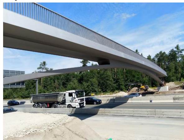
Figura 9. Vista del paso superior A400c.
