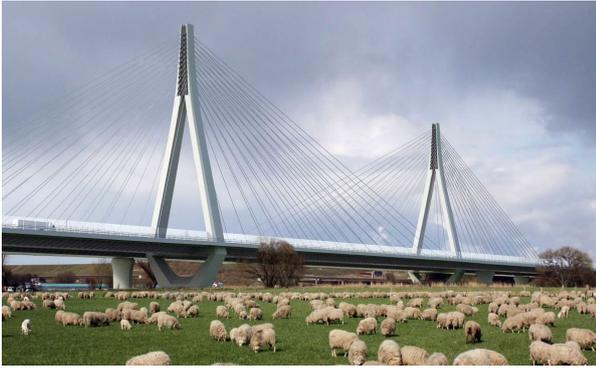
primera calzada de un nuevo puente que reemplace al existente. Esta calzada, de 34.15 m de ancho entre barreras, permitirá la adecuación de seis carriles incluso durante trabajos de inspección o mantenimiento de los cables. Una vez terminada se prevé su apertura al tráfico y desmantelación del puente existente, para la posterior construcción en su lugar de una segunda calzada gemela de la primera.
