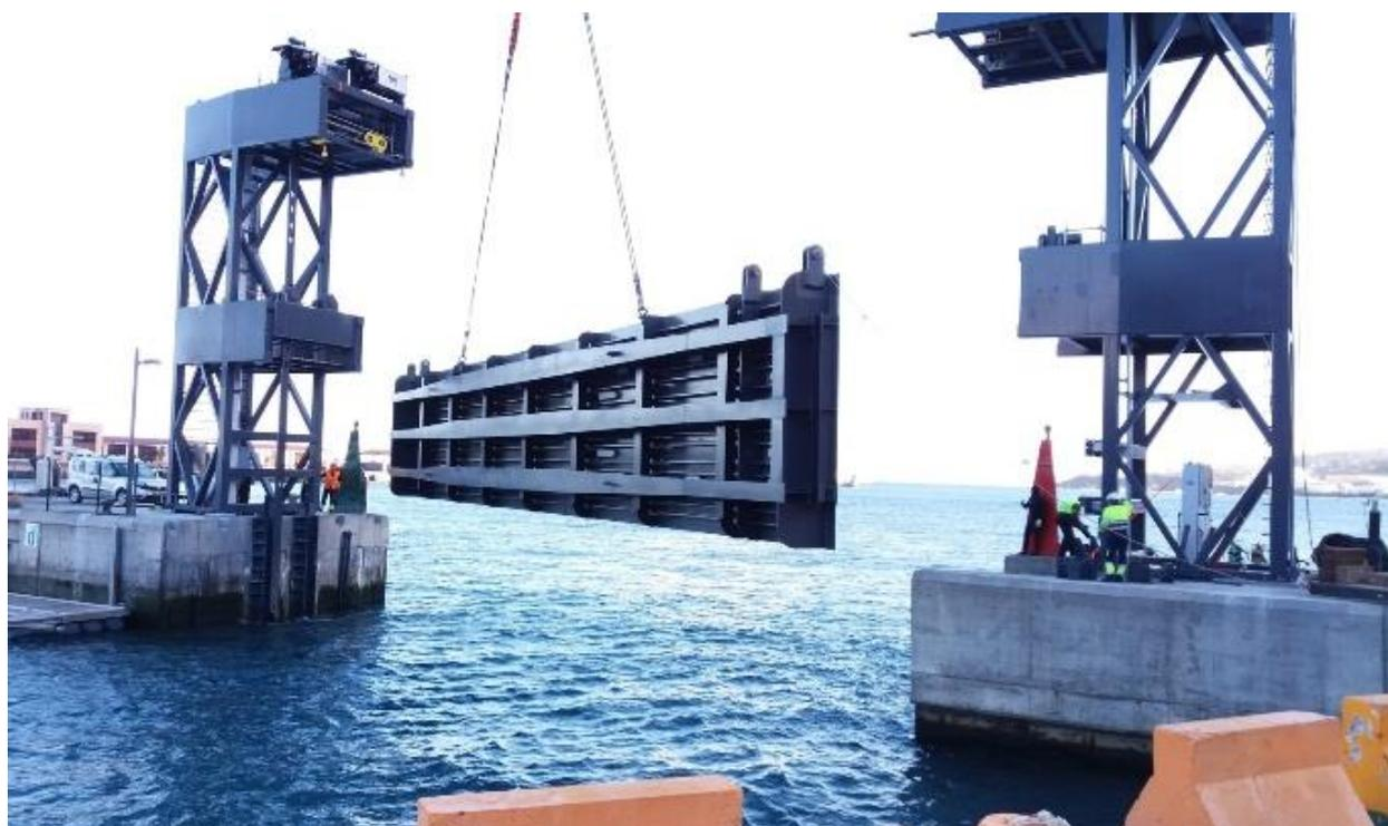
Figura 5. Colocación de compuertas durante la construcción.
