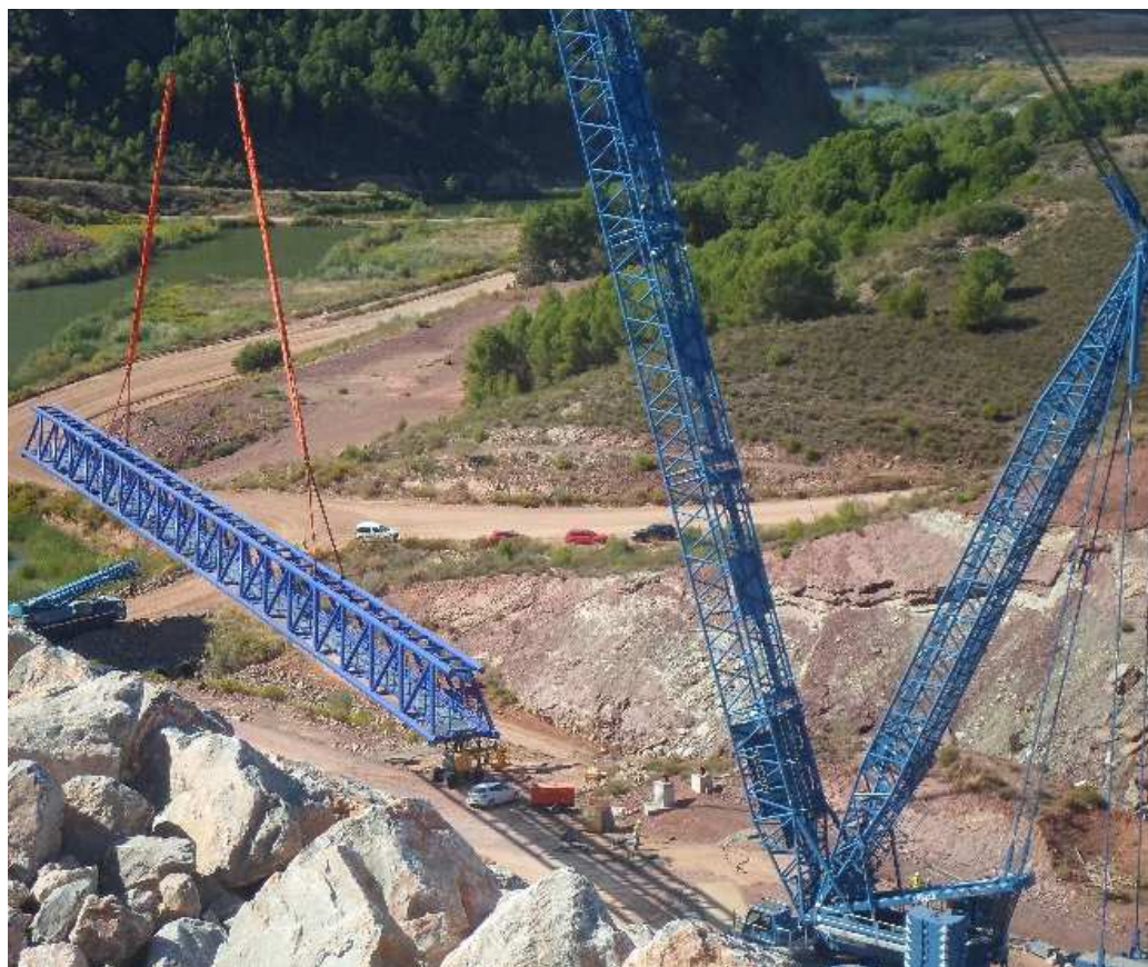
Figura 9. Izado de la pasarela
