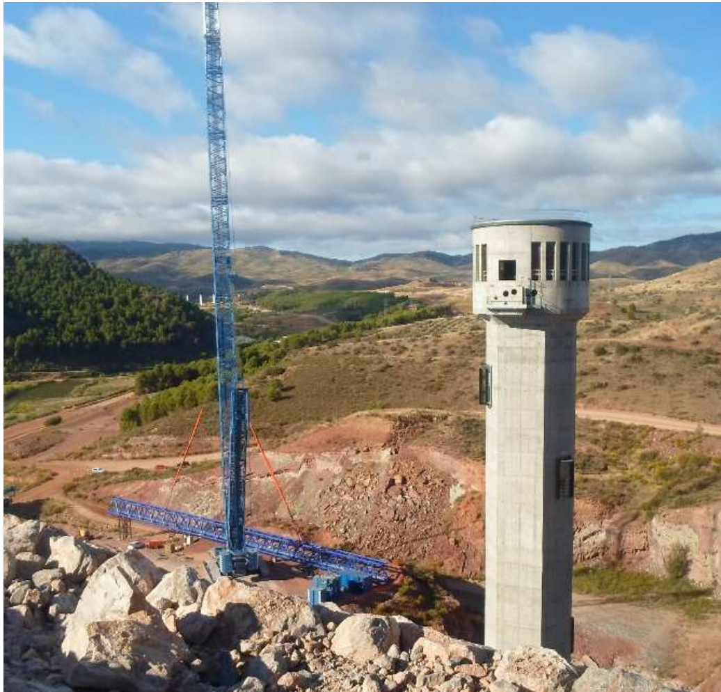
Figura 8. Estrobado de la pasarela
