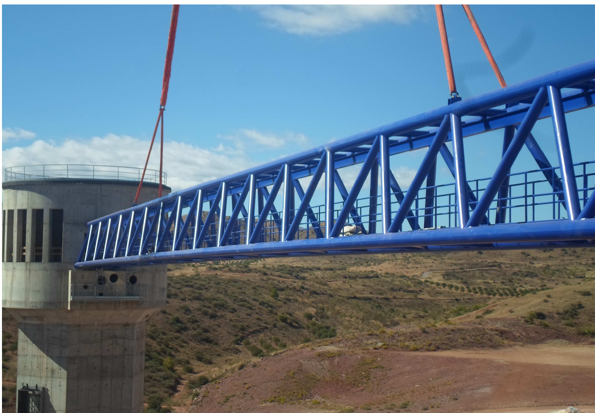
Figura 10. Posicionamiento de la pasarela
