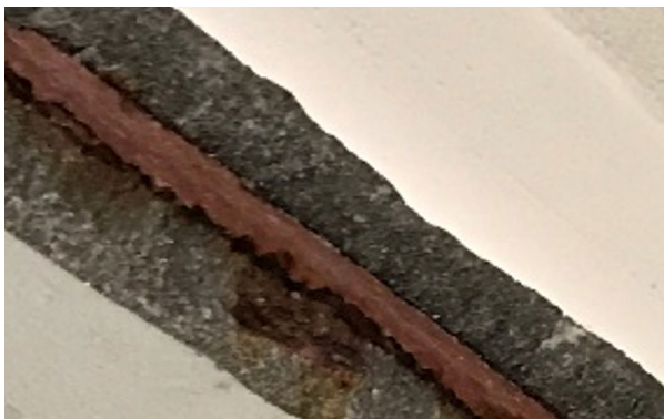
Figura 8. Armadura protegida con resina epoxi.
