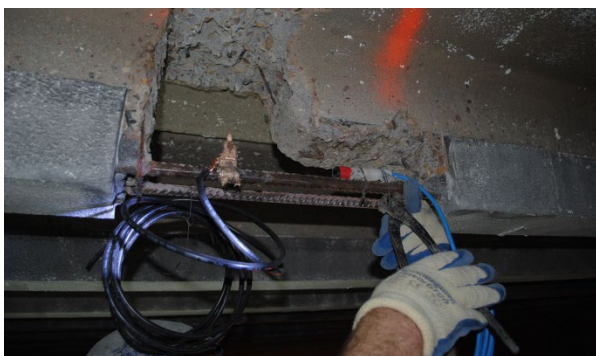
Figura 12. Implantación del sistema de protección catódica en la estructura.
