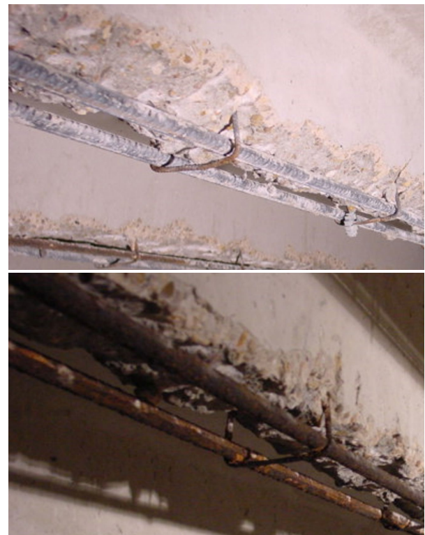
Figura 7. Comparación de la geometría de corruga en diferentes armaduras según grado de corrosión.
