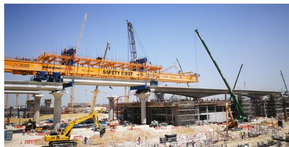
del soporte, se hace necesario conformar una estructura de 2 vanos continua de luces 44+44 m, utilizando la misma sección tipo en U que en los tramos isostáticos, con el canto sobre el apoyo central incrementada hasta los 2'33 m.
