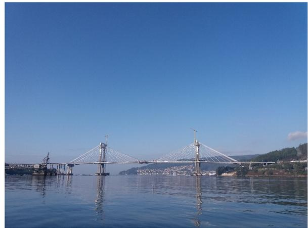
Además, cada dovela está unida a las torres ampliadas por medio de tirantes HD de Freyssinet. Los nuevos tirantes reproducen la alineación exacta de los existentes de forma que ambos conjuntos sean paralelos y homogéneos, ver Figura 2.
