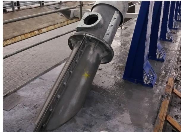
De igual manera los tubos guía debían ser compatibles con los tubos de encofrado y también se fabricaron en dos piezas, ver Figura 7.
