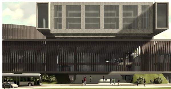
**Figura 6. Entrada principal. Viga vierendeel y vigas tubo**
