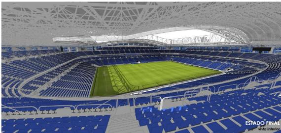
se sitúan en las esquinas del estadio. De las cerchas principales cuelga la subestructura metálica necesaria para colocar una cubierta textil de ETFE transparente que servirá de elemento de cubrición.
