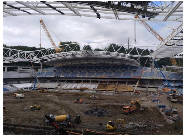
**Figura 26. Izado de la parte central de la cercha Oeste.**
