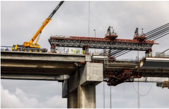
Figura 8.- Detalle de estructura de izado de dovela lateral lado Sur
