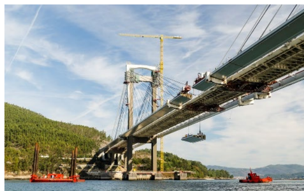
Figura 7.-Izado de dovela de cierre
