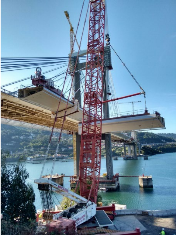
Figura 11.- Izado de dovela lateral lado Norte con grúa
