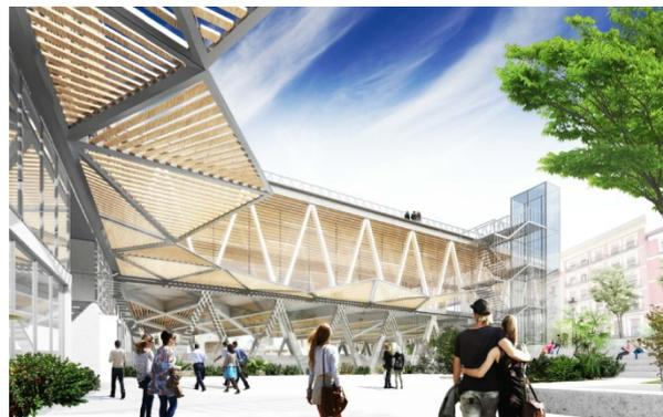
Aunque en un principio se pretendía que los puntos de apoyo estuvieran a la misma cota, se modificó su geometría para aprovechar el funcionamiento por forma del voladizo generado, la diferencia de cota entre los puntos de anclaje, permitía conseguir el canto necesario para que los perfiles funcionaran a tracción y compresión, en lugar de a flexión (Figura 13).
