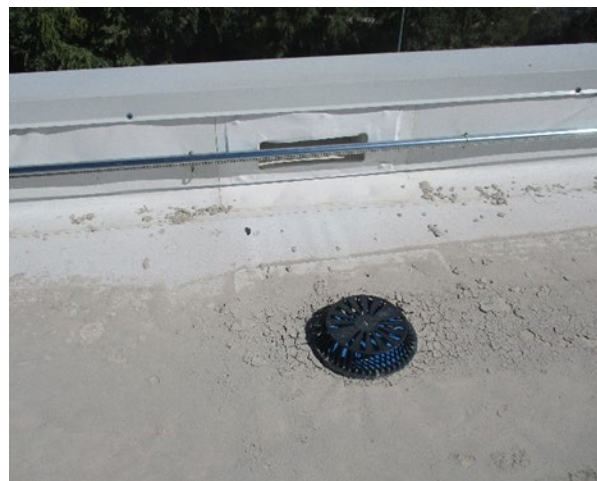
Figura 3. Sistema de drenaje sifónico.
