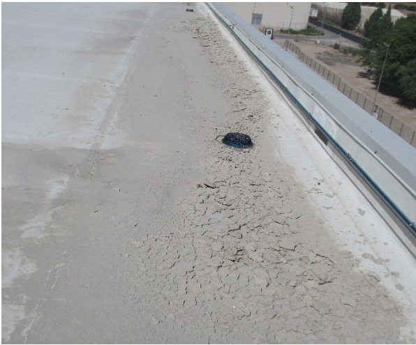
Figura 5. Formación de costra entre puntos de desagüe.
