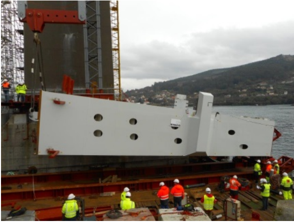
Figura 4.-Vista de plataforma de trabajo
