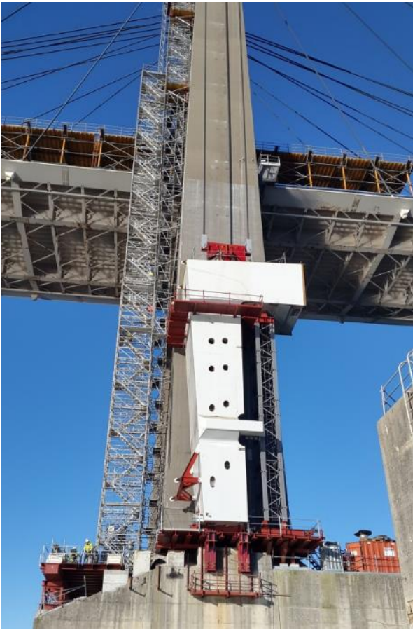
Figura 2. Izado de la pieza del hombro
