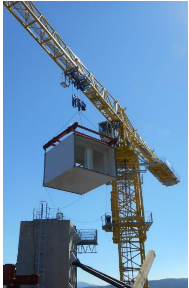
Figura 1.-Izado de una de las piezas que forma parte del dintel.
