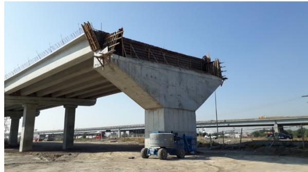
Las pilas de la estructura son de diversas tipologías, en función de los obstáculos y servidumbres adyacentes. Las pilas P18, P36, P37, y P48 son del tipo martillo con monofuste (Fig. 9). Las pilas P15, P16, P19, P38 a P40, P42 a P47 son de tipo pórtico de hormigón con luces y voladizos de longitud variable (Fig. 10). La P41 es una pila pórtico singular con dintel mixto hormigón-acero (Fig. 11).
