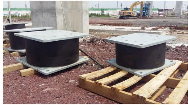
Estos aparatos de apoyo, a fin de que sean eficientes en el aislamiento y disipación de la de la estructura frente a la acción sísmica deben ser flexibles, y ser capaces de absorber un desplazamiento elevado manteniendo su capacidad de carga vertical. En consecuencia, el término que gobierna el diseño de este tipo de aparatos de apoyo es, frecuentemente, su estabilidad frente a cargas verticales concomitante con el desplazamiento horizontal máximo de situación sísmica.
