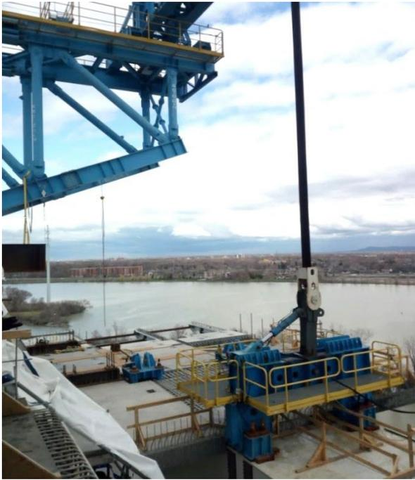
**Figura 14. Balancín de izado**
