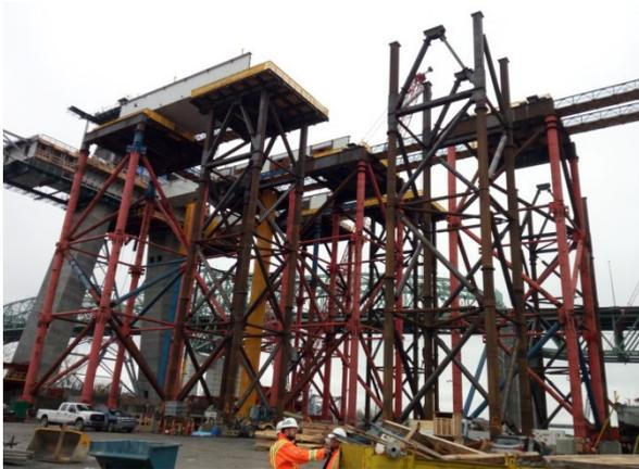
Por último, se realizaba el tesado de los tirantes, reduciendo progresivamente la reacción sobre las torres centrales hasta descargarlas completamente. Se previó el uso de gatos hidráulicos para ayudar al desapeo
