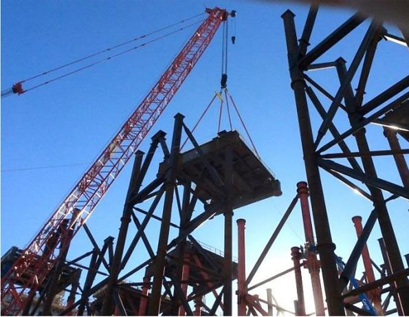
Figura 9. Izado de un cabecero de torre
