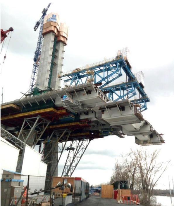
Figura 12. Delta Frame y avance en voladizos del Main Span mediante carro de izado
