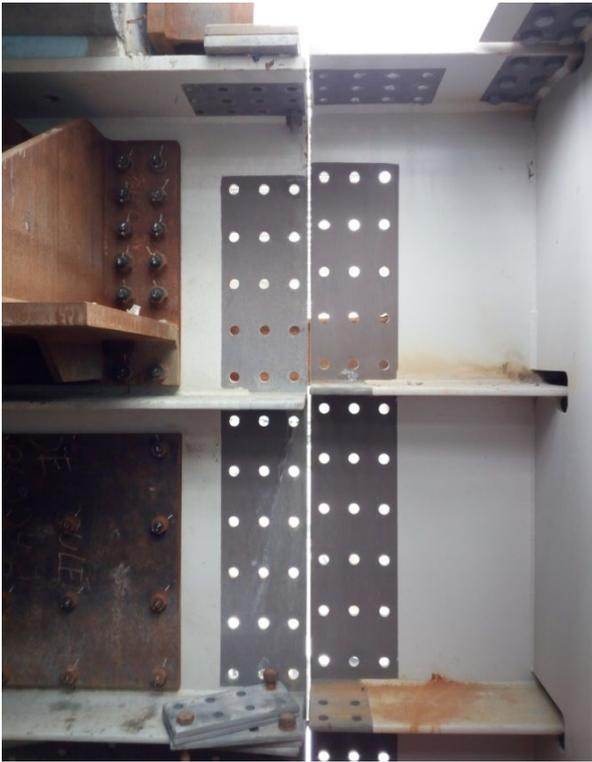
**Figura 17. Desalineación entre dovelas**
