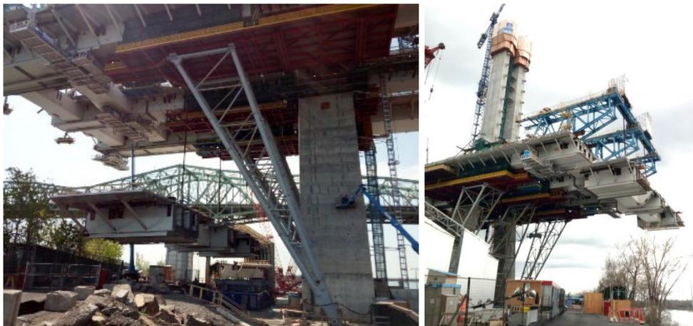
Figura 18. Izado de primeras dovelas tipo. Apoyo de primeras dovelas en el delta frame
