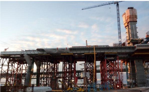
Figura 9. Ejecución del Back Span sobre las torres provisionales de apeo
