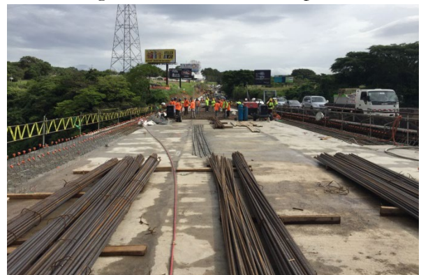
Figura 19. Hormigonado de la losa del tablero
