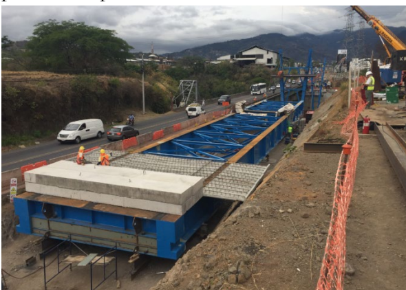
Figura 13. Semitablero lado norte listo para el empuje con los contrapesos y prelosas.
