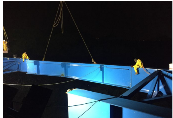
Figura 18. Colocación de una viga del tramo central
