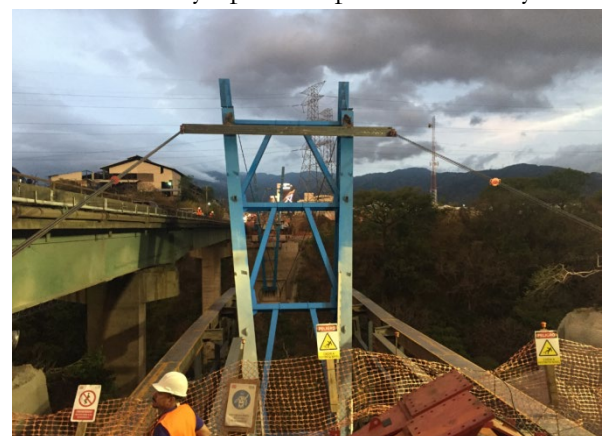
Figura 11. Volteo de la pila norte
