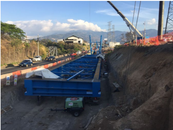
Figura 12. Alineación y montaje del semitablero norte
