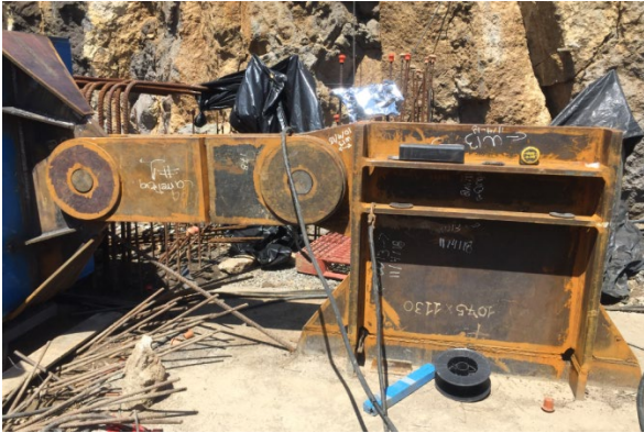
Figura 16. Punto fijo en el trasdós del estribo norte
