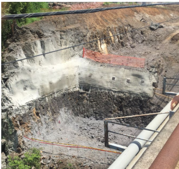
Figura 6. Excavación de la zona superior de la pila norte
