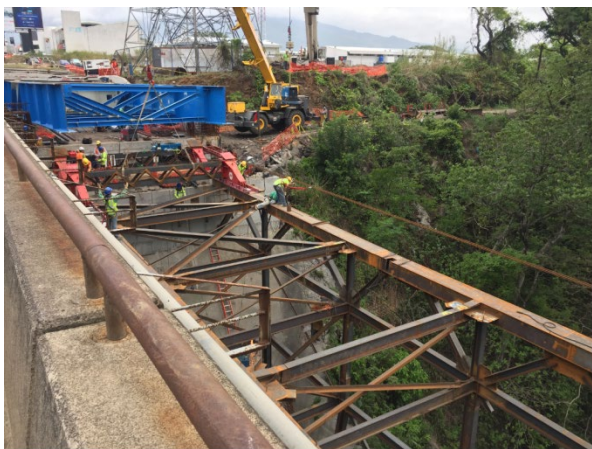
Figura 14. Vista de la estructura auxiliar lado sur en fase de montaje antes del empuje
