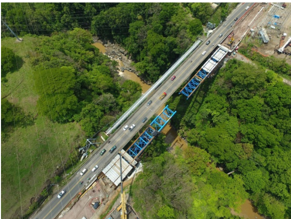
Figura 17. Vista aérea del puente antes de la colocación del tramo central
