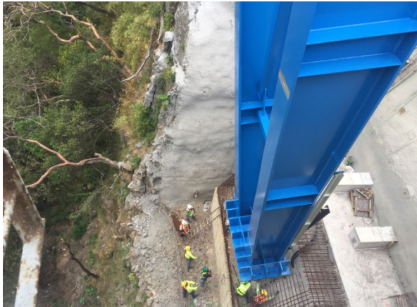
Figura 9. Puesta en obra de la pila norte
