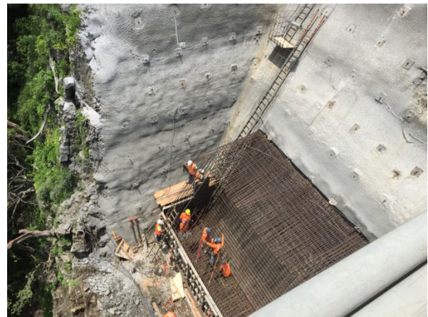
Figura 7. Colocación del ferralla en zapata de pila norte
