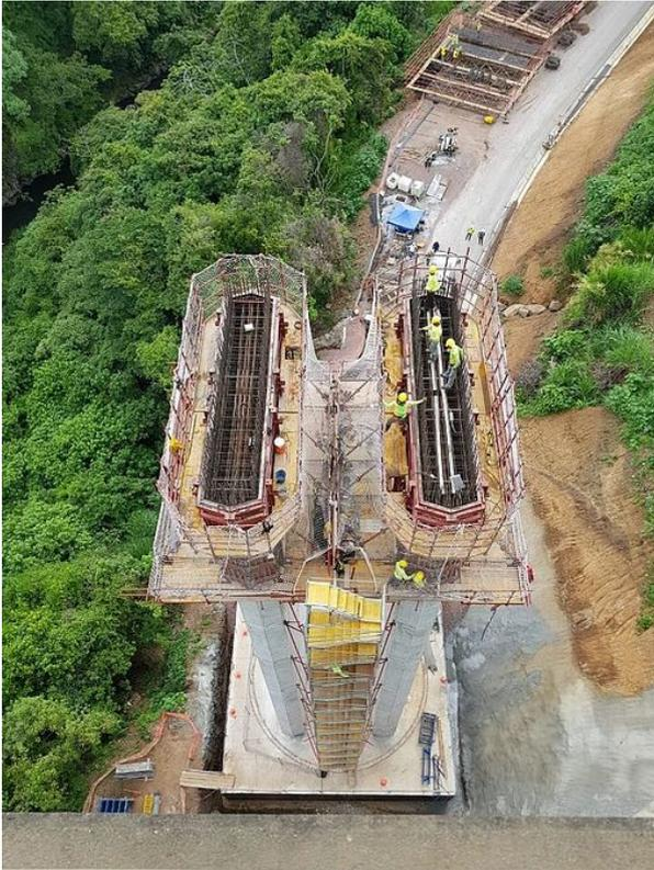
Figura 11. Trabajos en trepa 6 de pila 2
