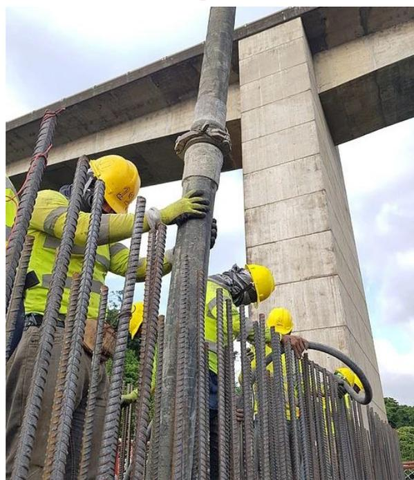
**Figura 10. Trabajos de hormigonado de cimentación de pila 2**
