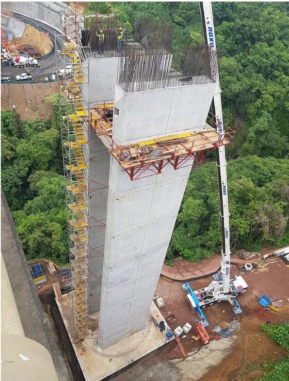
Figura 12. Pila 2 finalizada hasta el nivel inferior de la dovela cero
