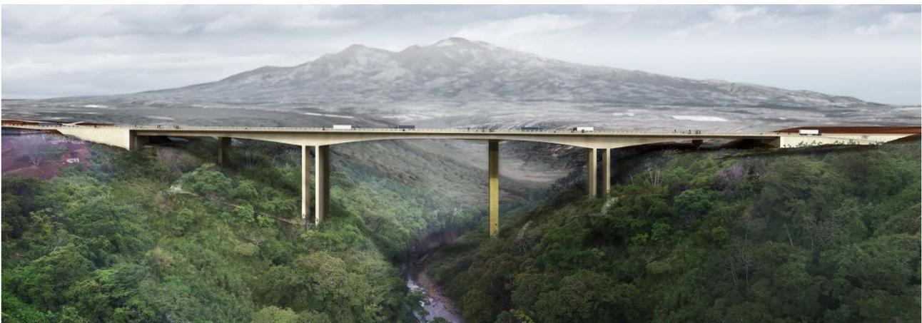
**Figura 2. Fotomontaje del puente proyectado, pilas coincidentes con dos de las pilas del existente**
