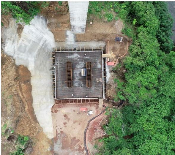
**Figura 4. Planta de la cimentación de una de las pilas, y arranque antes del hormigonado**
