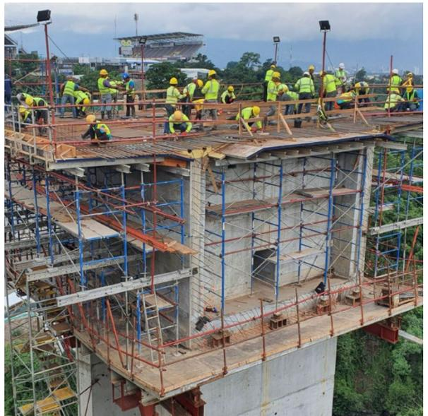
Figura 14. Hormigonado de losa superior de dovela cero de P-2
