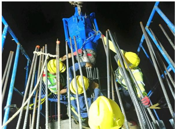
Figura 15. Tesado de dovela cero en P-2
