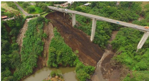
**Figura 6. Deslizamiento de rellenos en la zona próxima al estribo sur. Octubre de 2017**
