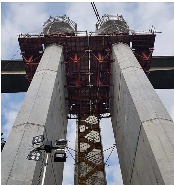
**Figura 5. Alzado lateral de una de las pilas en la fase final de su ejecución**
