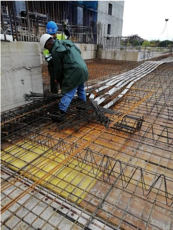
La longitud de los tendones de basamento llegaba en algún caso hasta los 89.43 m, no siendo posible realizar un tesado desde ambos extremos por encontrarse uno de ellos en contacto con la estructura existente, y por tanto careciendo de accesibilidad.
