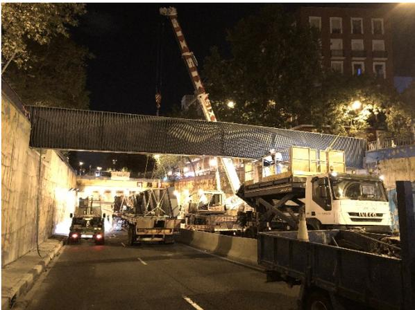
**Figura 9. Izado de primera viga principal.**
