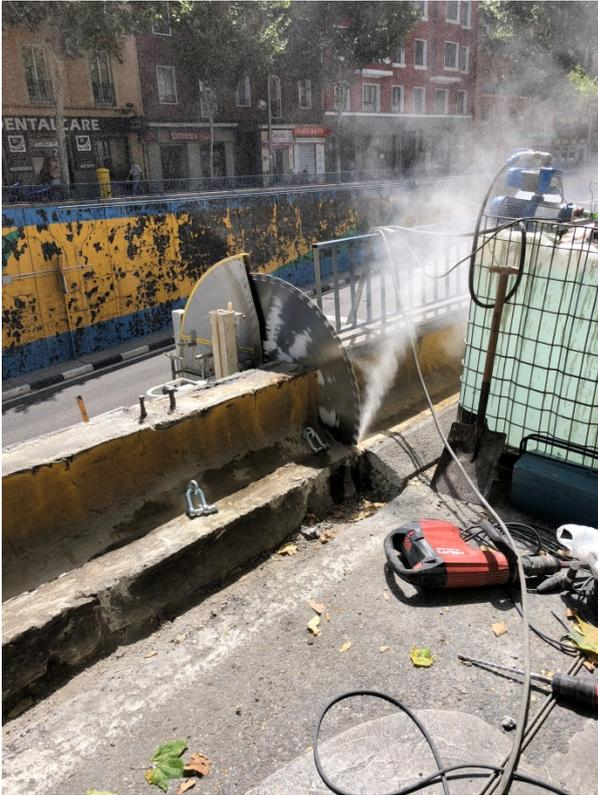
**Figura 8. Corte de muro con disco**
