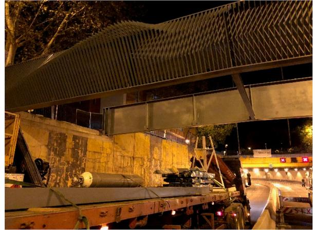
Tras el montaje de las vigas longitudinales, con un nuevo corte nocturno, se procedió a la colocación de las correas transversales.
