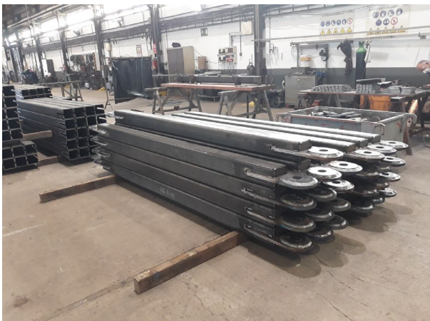
Figura 8. Premontaje de diagonales en taller.
