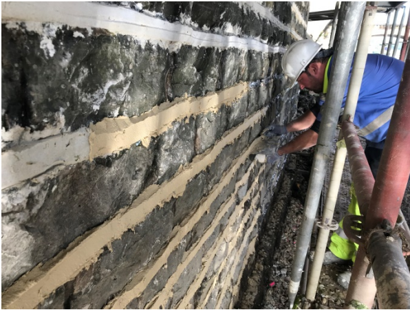
Figura 21. Trabajos de rejuntado en paramentos de estribo lado Irún
