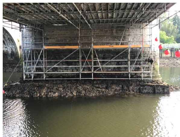
Figura 19. Andamios en pilas, colgados del andamio principal, vista frontal
