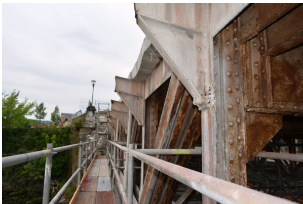
Figura 17. Restos de piezas de voladizo cortadas tras la colocación del andamio
