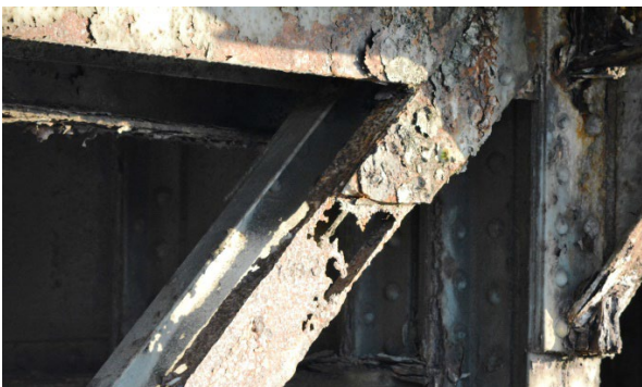
Figura 14. Imagen de una de las diagonales tomada durante la inspección especial
