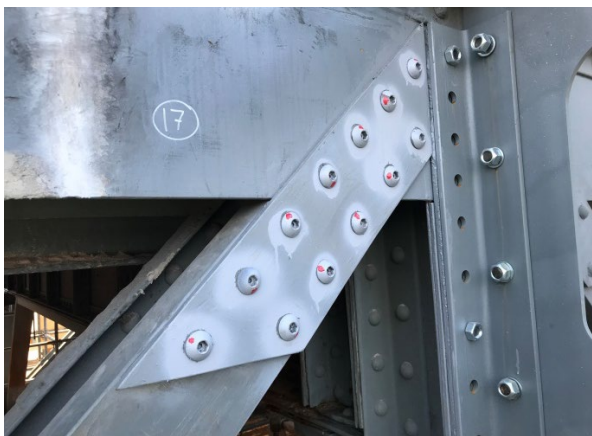
Figura 27. Unión diagonal – montante – voladizo
