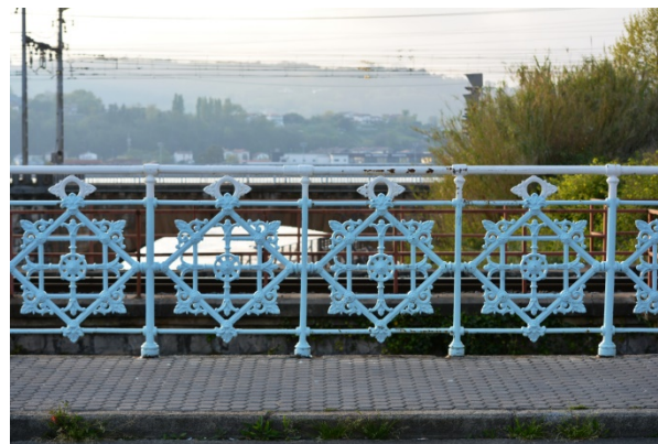
Figura 12. Barandilla, similar a la del puente de Sagasta o puente de Hierro de Logroño
