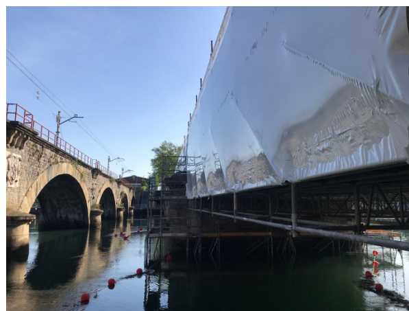
Figura 20. Andamio encapsulado con plástico termoretráctil
