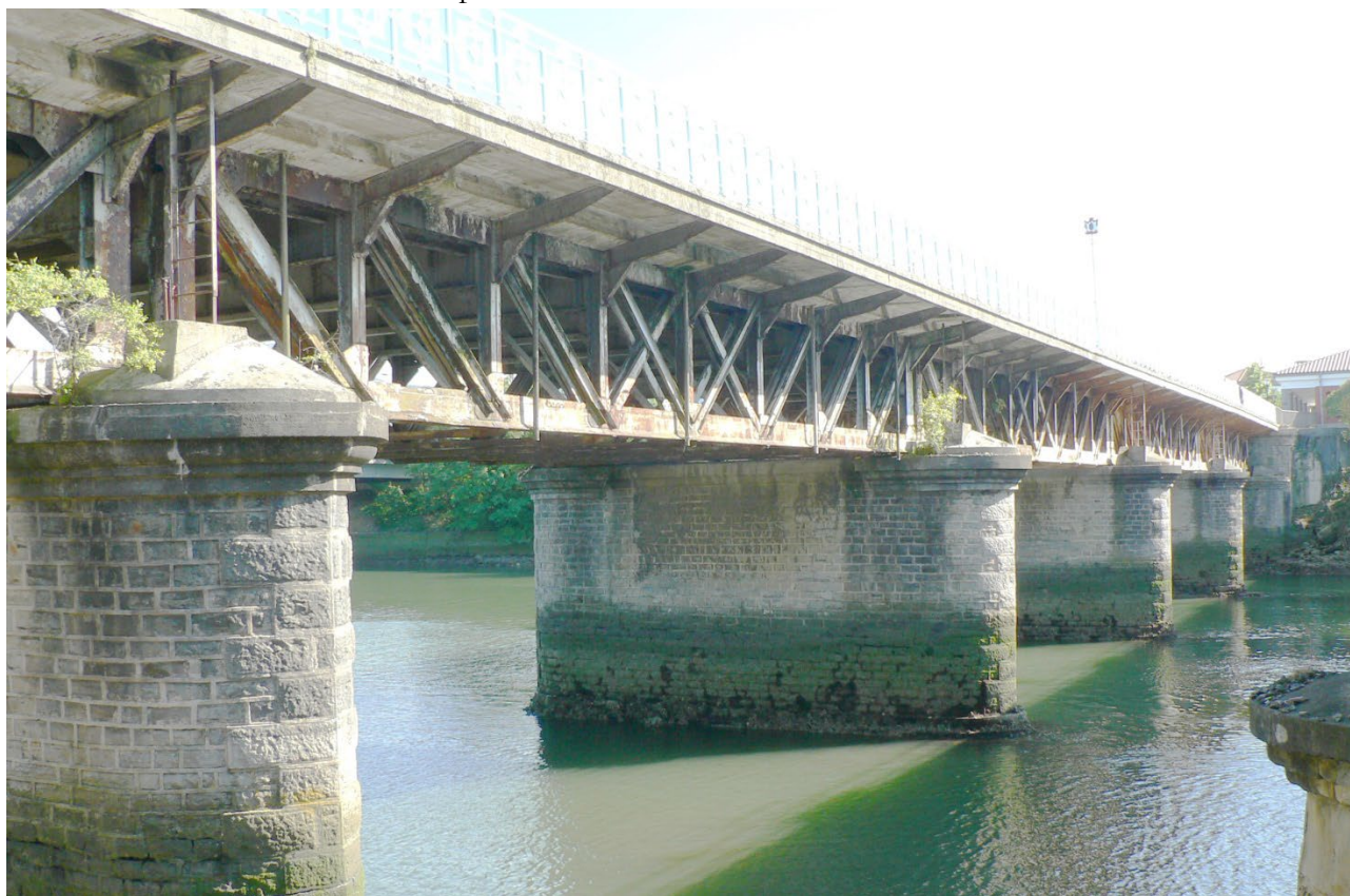
Figura 13. Vista en perspectiva del puente Avenida desde el puente ferroviario
