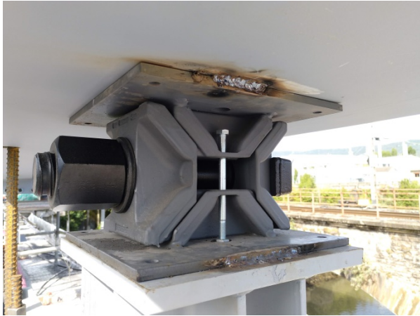
Figura 24. Gatos de cuñas de apoyo de vigas de apeo
