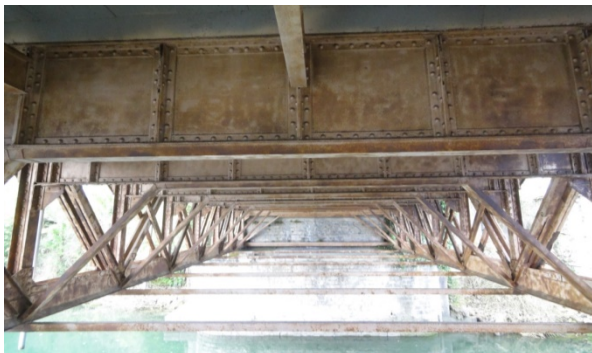
Figura 8. Vista inferior del tablero. Travesaños, largueros y arriostramiento actuales
