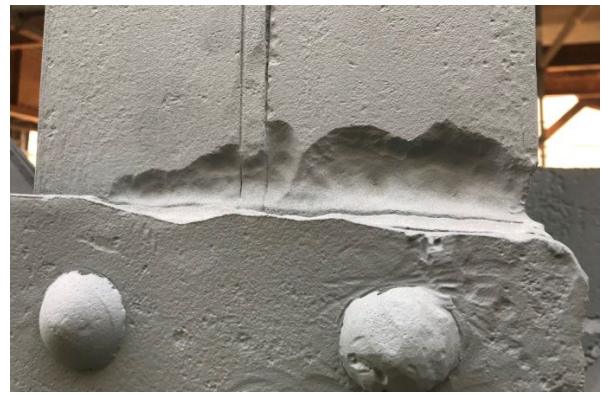
Figura 25. Reducción de espesor localizada en nudo detectada tras chorrear
