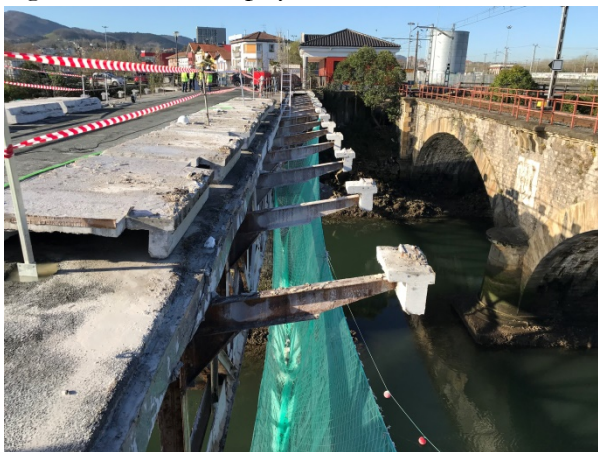
Figura 16. Corte de las voladas y acopio en el tablero existente
