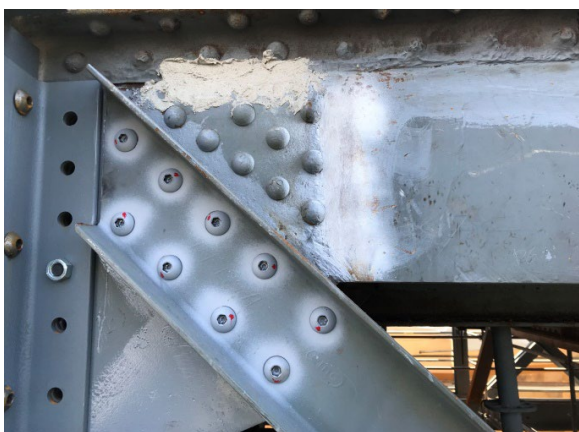
Figura 28. Unión diagonal – cordón superior
