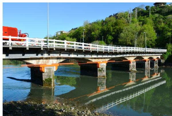
**Figura 11. Tirantes dispuestos a nivel de arranque de bóvedas para impedir corrimientos horizontales**
