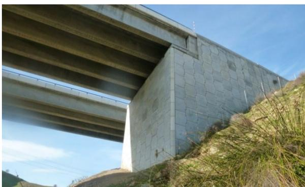
Figura 12. Estribo tipo de suelo reforzado
