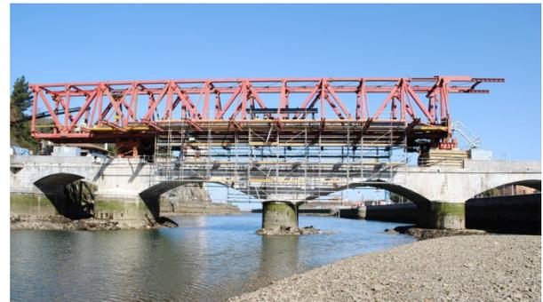
Tras la conclusión de la obra de emergencia se encuentran recalzadas las pilas 1 y 3, mientras que las bóvedas 2 y 3 están sostenidas por encofrados colgados de una cimbra apoyada en el propio puente, sobre las pilas recalzadas.
