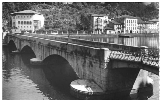
Figura 4. Puente de Deba antes de la eliminación del tramo metálico móvil en 1955
