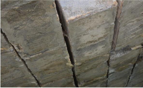
En el tajamar de aguas arriba de la pila 3 existe una separación entre los tendeles de los sillares de, al menos, 2 cm en altura (fig. 15).
