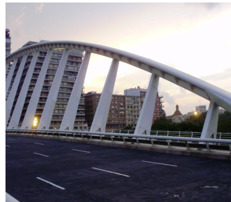
Figura 4. Ejemplo de péndolas empotradas. Puente de La Alameda, Valencia. Fuente: Juan José Jorquera Lucerga.
