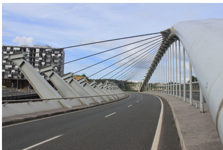
Figura 5. Puente sobre el río Galindo, España.
