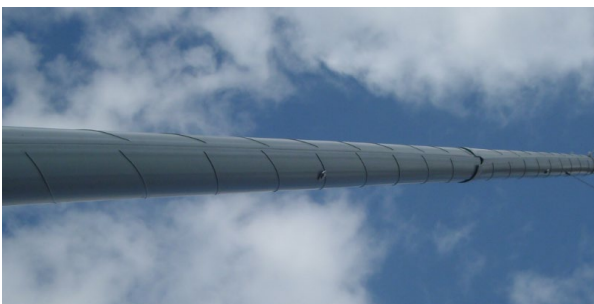
Figura 8. Vaina en semi cáscaras estándar de Freyssinet
