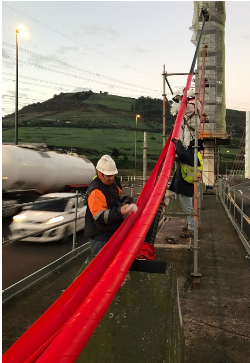
Figura 9. Instalación de vaina global
