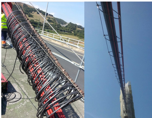
Figura 6. Detalle malla de seguridad
