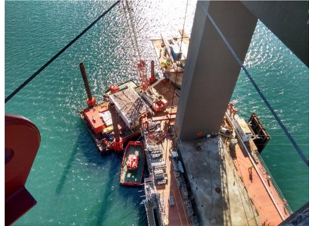
**Figura 13. Ensamblaje de las dovelas iniciales en el lado grúa torre**
