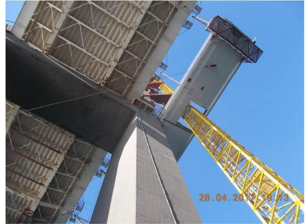
Figura 4. Hueco en dovela inicial para paso de grúa torre
