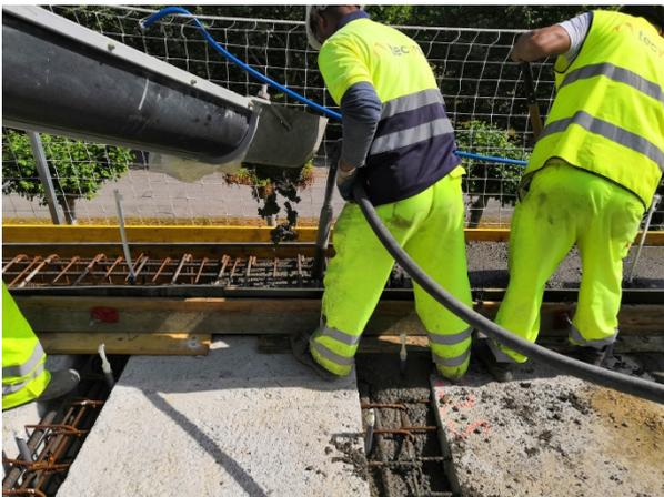
Figura 22. Hormigonado de juntas y pedestal de pretil
