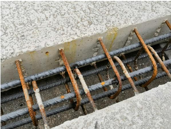
Figura 21. Juntas entre losas antes del hormigonado
