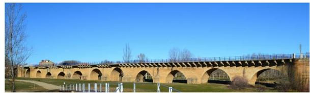
Antes de la intervención, la plataforma del puente expuesta al tráfico constaba de 6 m con dos carriles de 3 m, con un espesor de aglomerado de 15 cm, aceras de 1 m de ancho y 20 cm de espesor y barandillas laterales simples.
