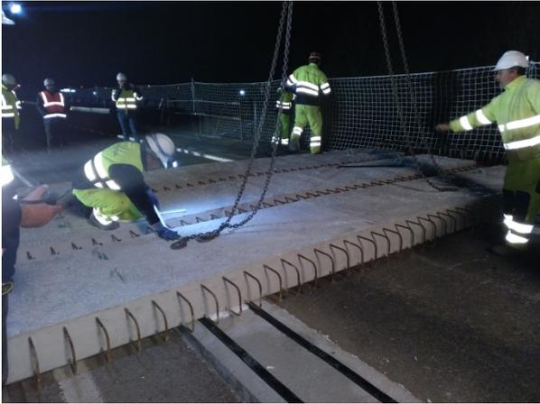
Figura 20. Colocación de prelosa
