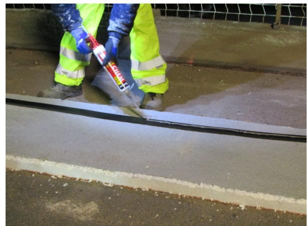
Figura 19. Detalle de banda de neopreno que mejora el apoyo de la prelosa
