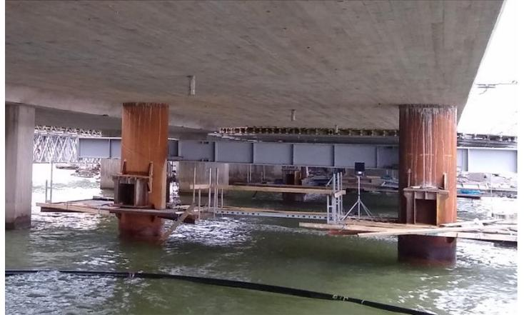
Figura 19. Imagen ménsula pila central
