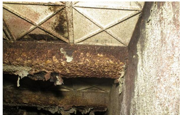
**Figura 5. Degradación por ataque ácido en pozo.**
