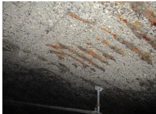
**Figura 1. Ataque ácido en bóveda de digestor.**
