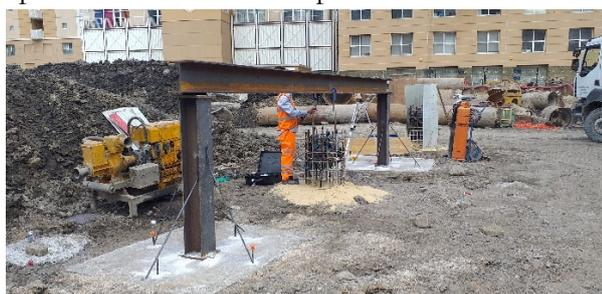
Figura 14. Preparación del ensayo O-Cell® en obra
