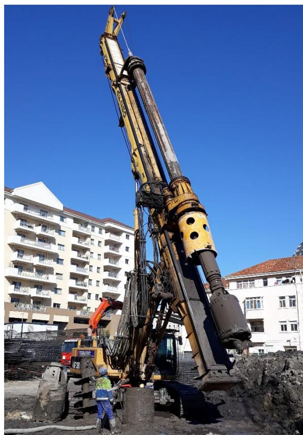
Figura 15. Ejecución de uno de los pilotes en obra
