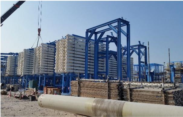
Figura 7. Racks de apoyo de tuberías de proceso.
